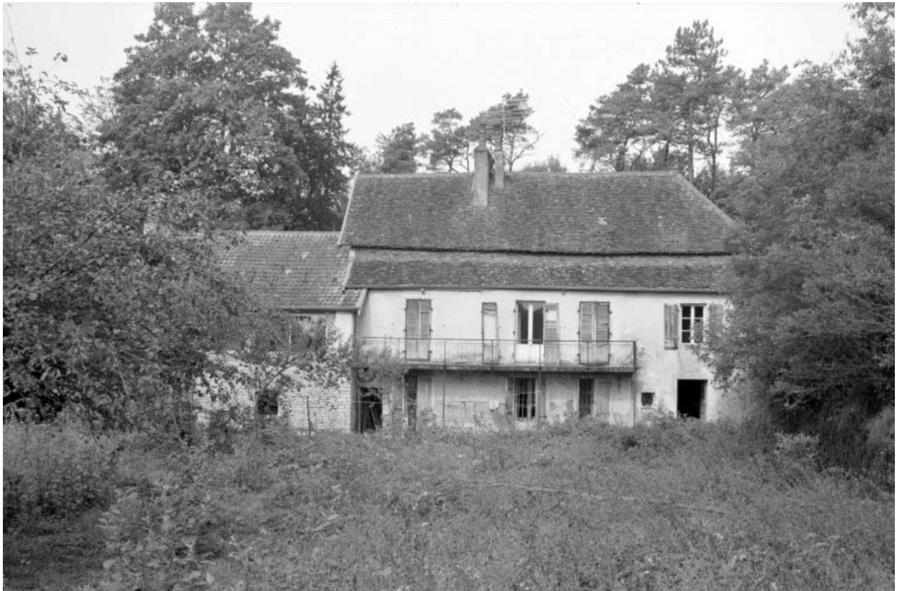
Façade latérale droite du logement patronal.
