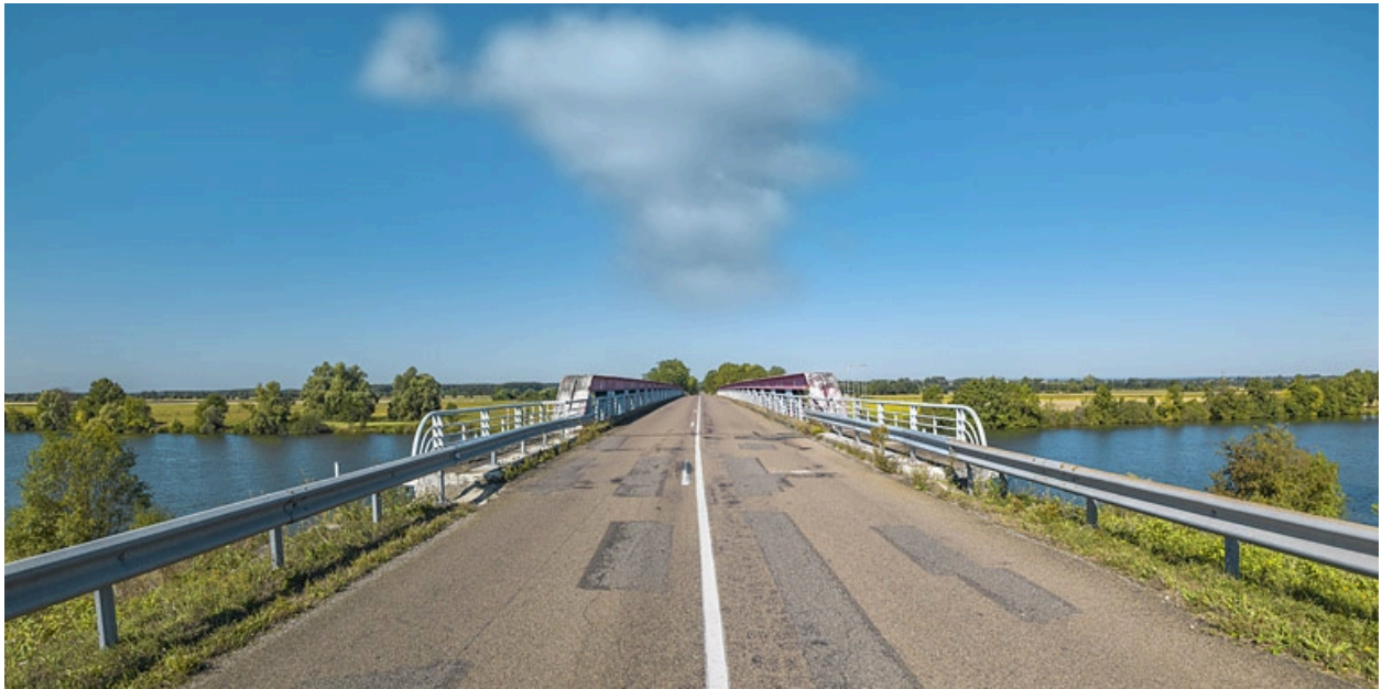
Vue d'ensemble du tablier du pont.
