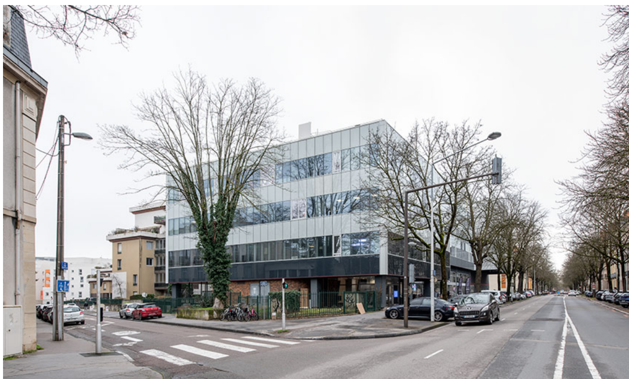
Situation sur le boulevard Carnot, vue depuis le nord.
