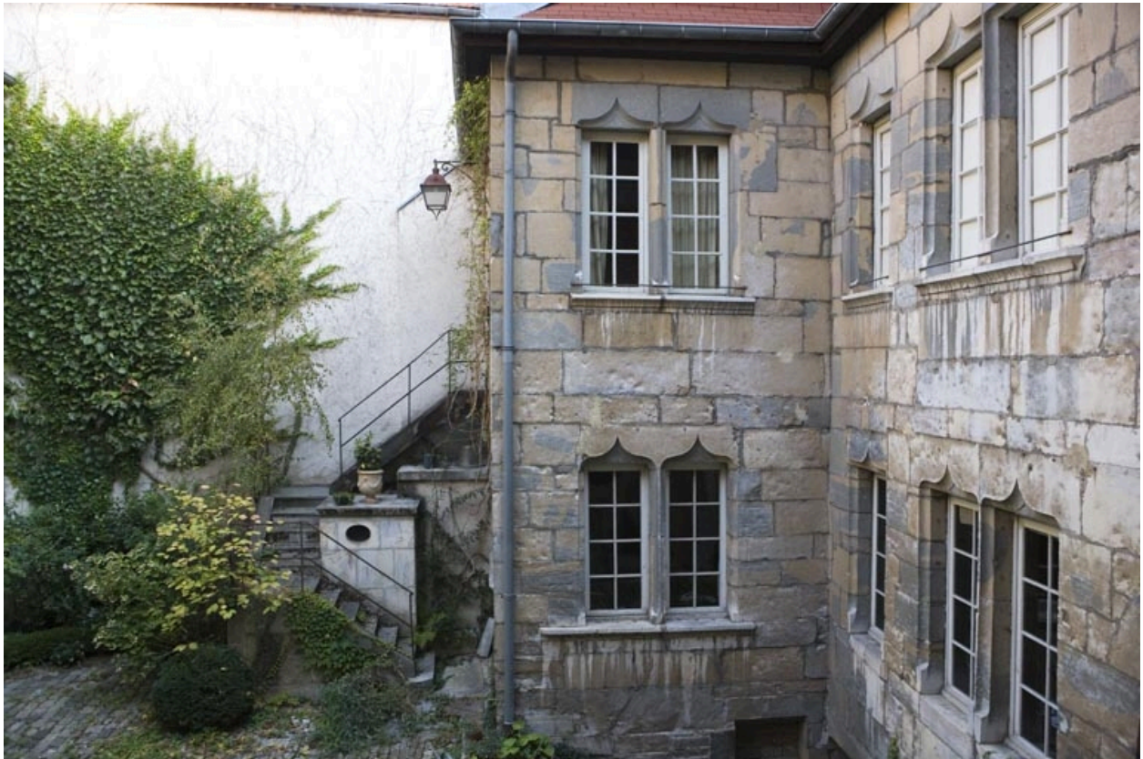
Aile du logis, façade latérale.
