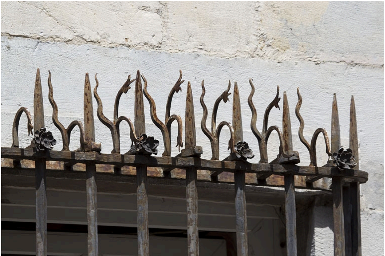
Façade sur rue du logis principal : détail de la partie supérieure des grilles devant les fenêtres du rez-de-chaussée.
