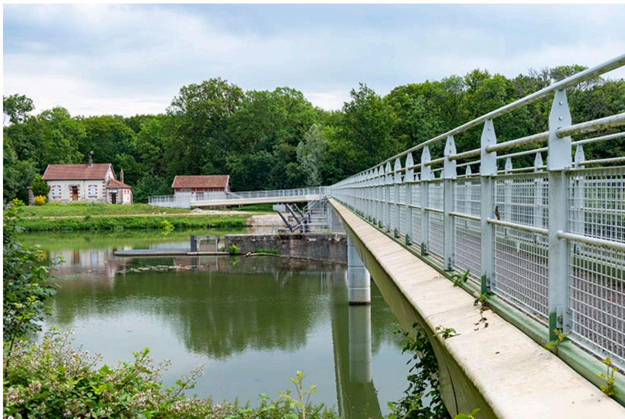
La passerelle au dessus de la Saône et la maison du barragiste.
