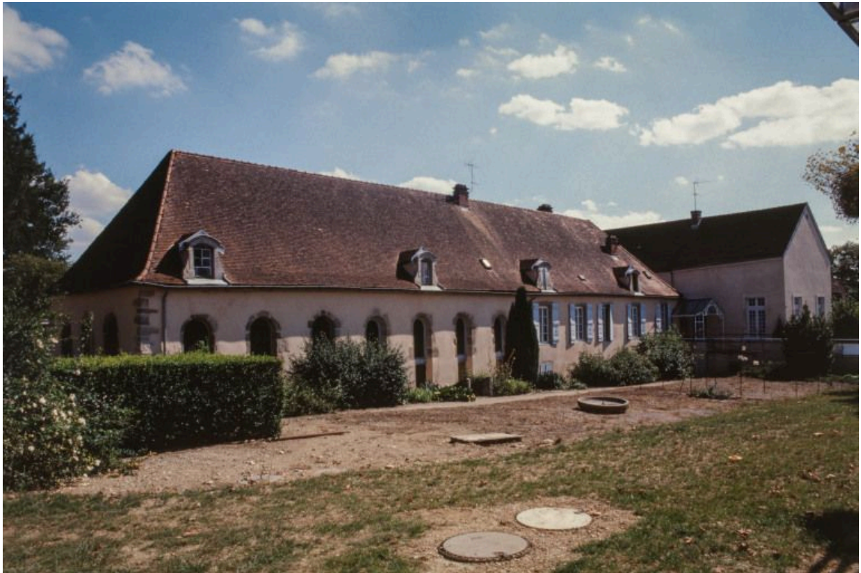
Vue générale de l'ancien hôpital, façade postérieure.
