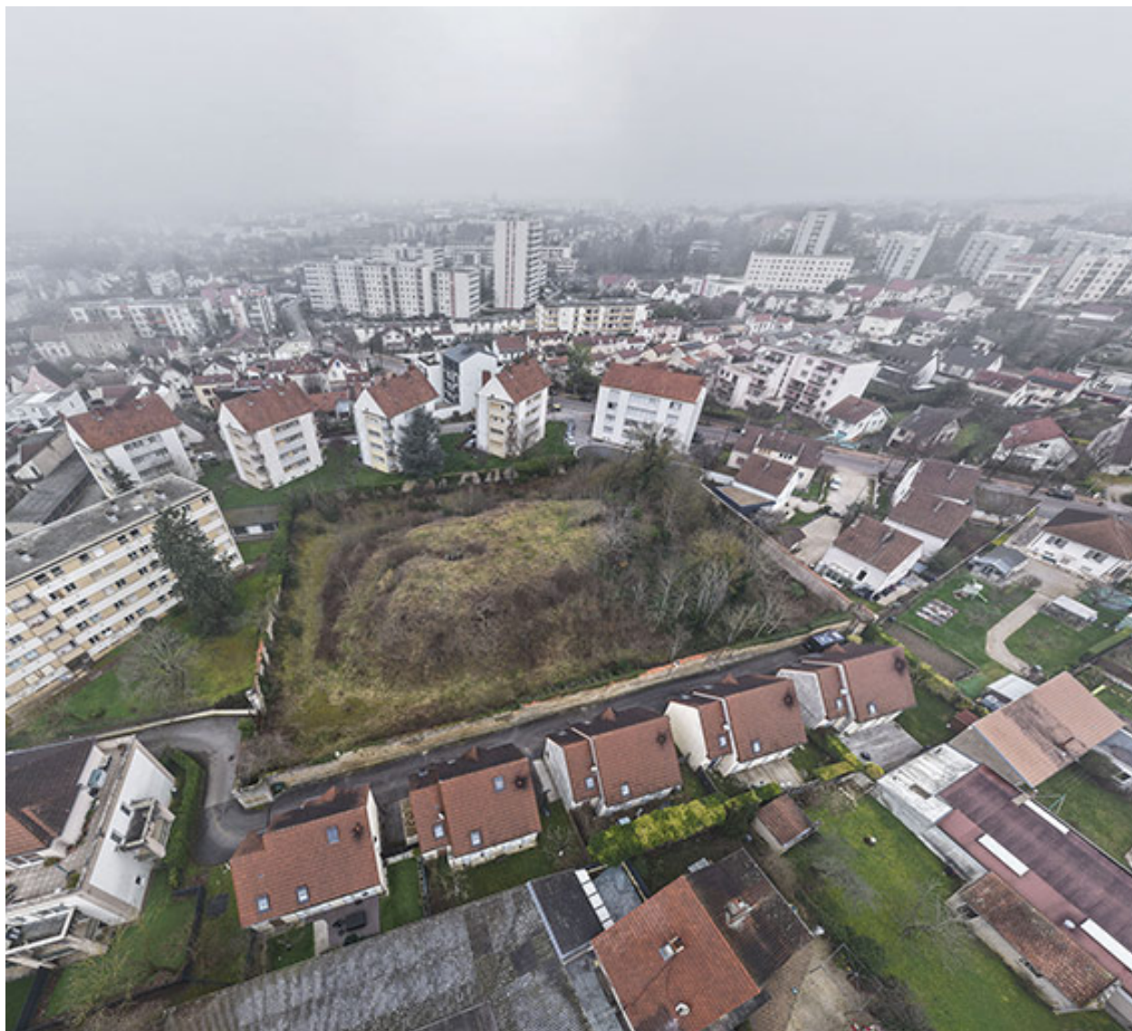
Poudrière, rue d'Auxonne. (vue aérienne).
