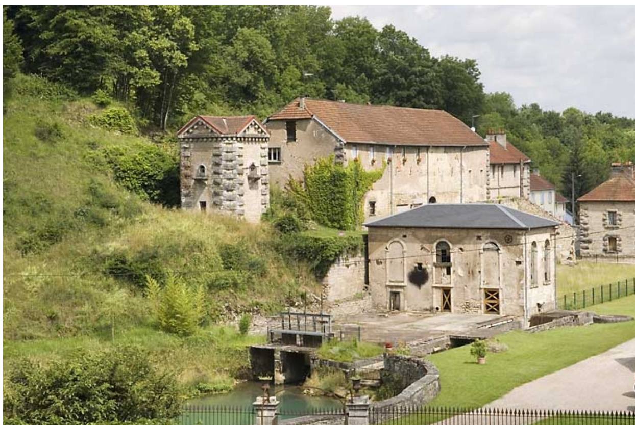
Vue d'ensemble des bâtiments de production depuis l'est.
