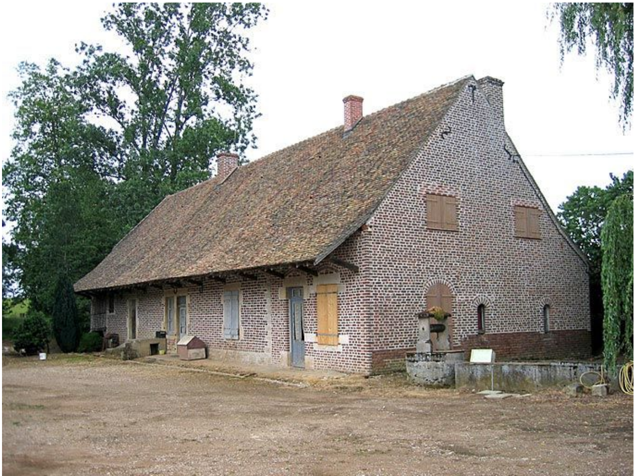
Vue d'ensemble de la façade de 3/4 droit.
