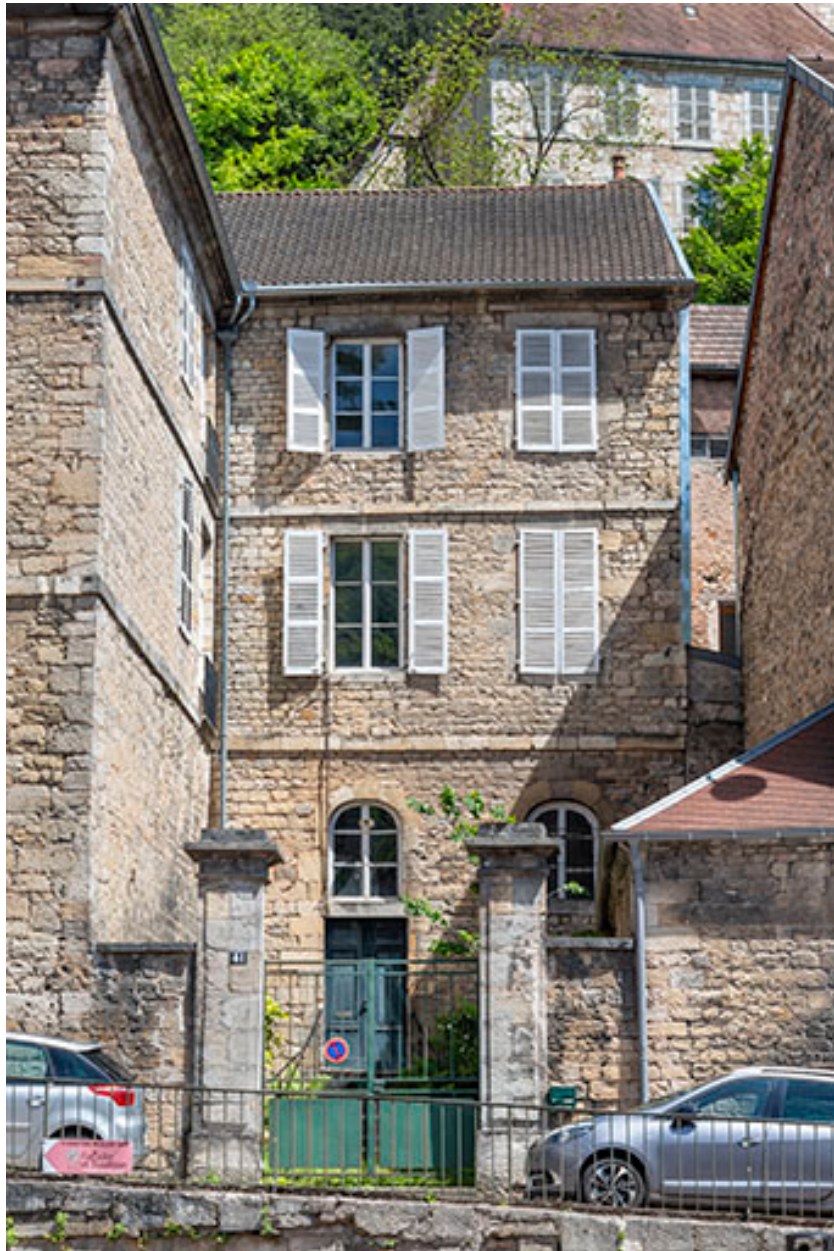
Façade ouest du bâtiment sur cour.
