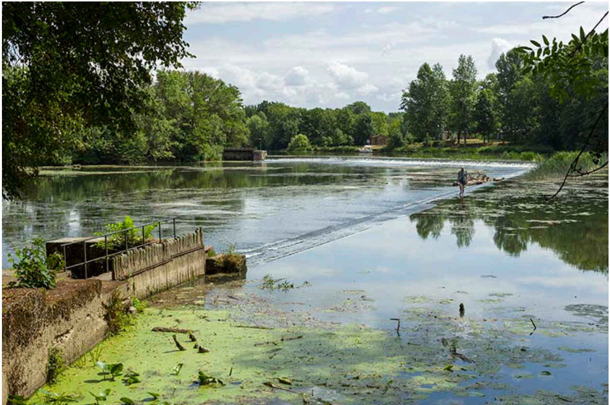
Ancien barrage usinier et la Saône.
