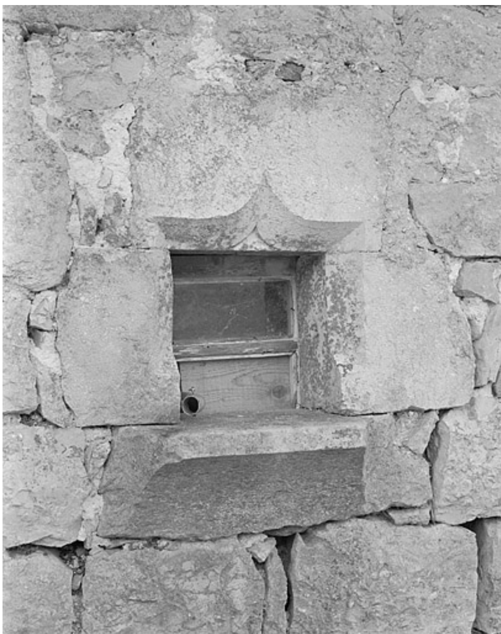
Fenêtre en accolade sur la façade postérieure.
