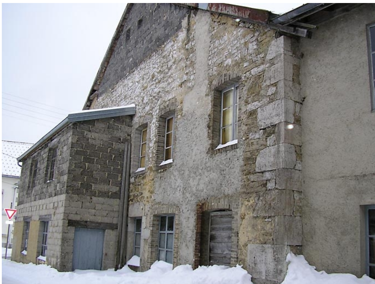
Façade nord-est et appentis.
