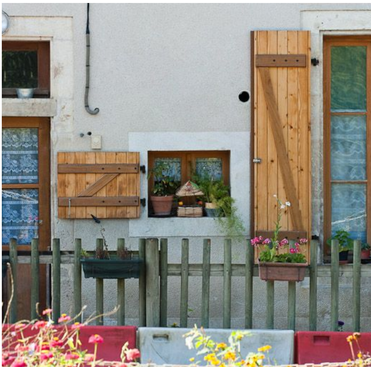
Détail des baies de la maison éclésièr.
