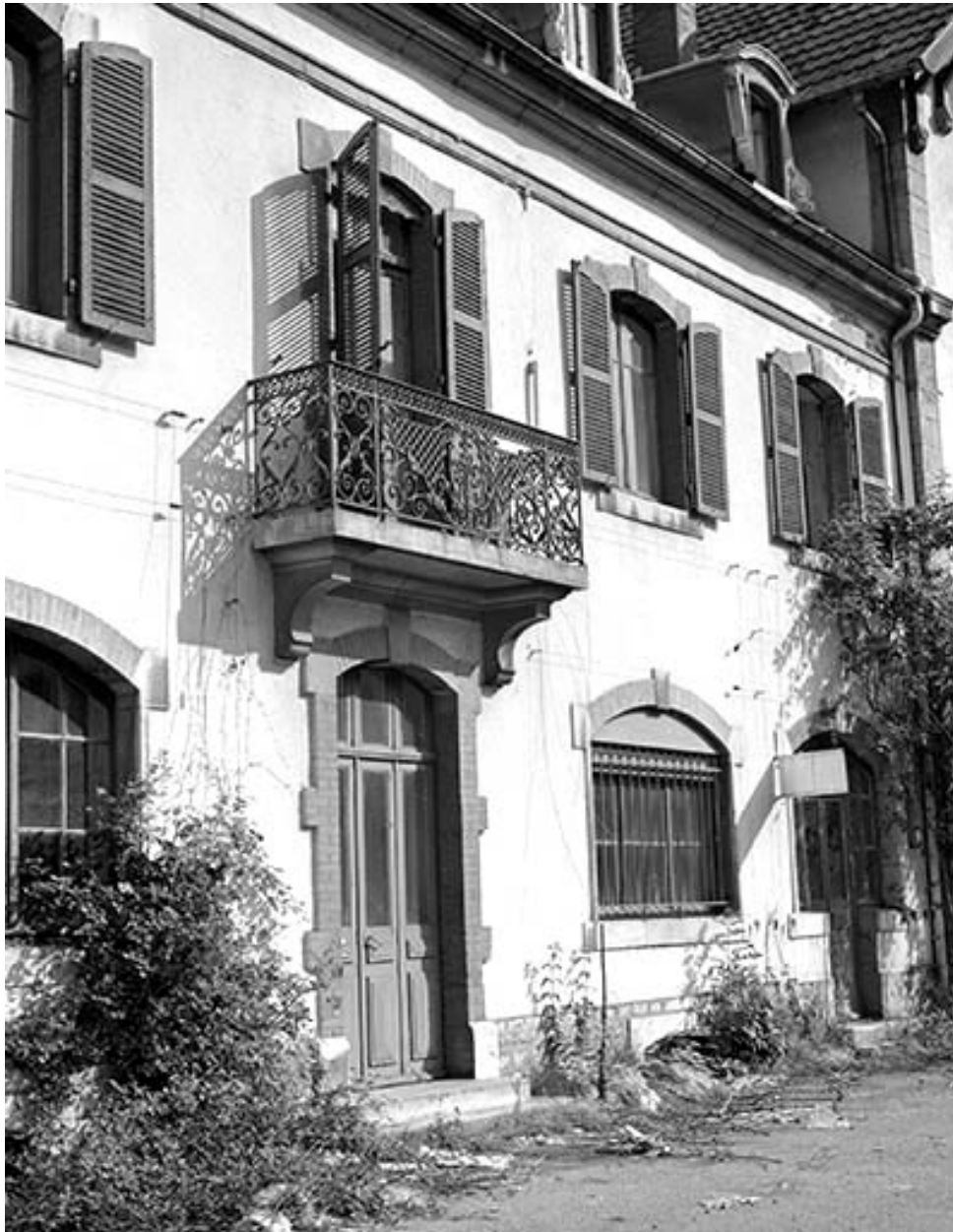
Entrée des bureaux (extrémité occidentale) et balcon.
