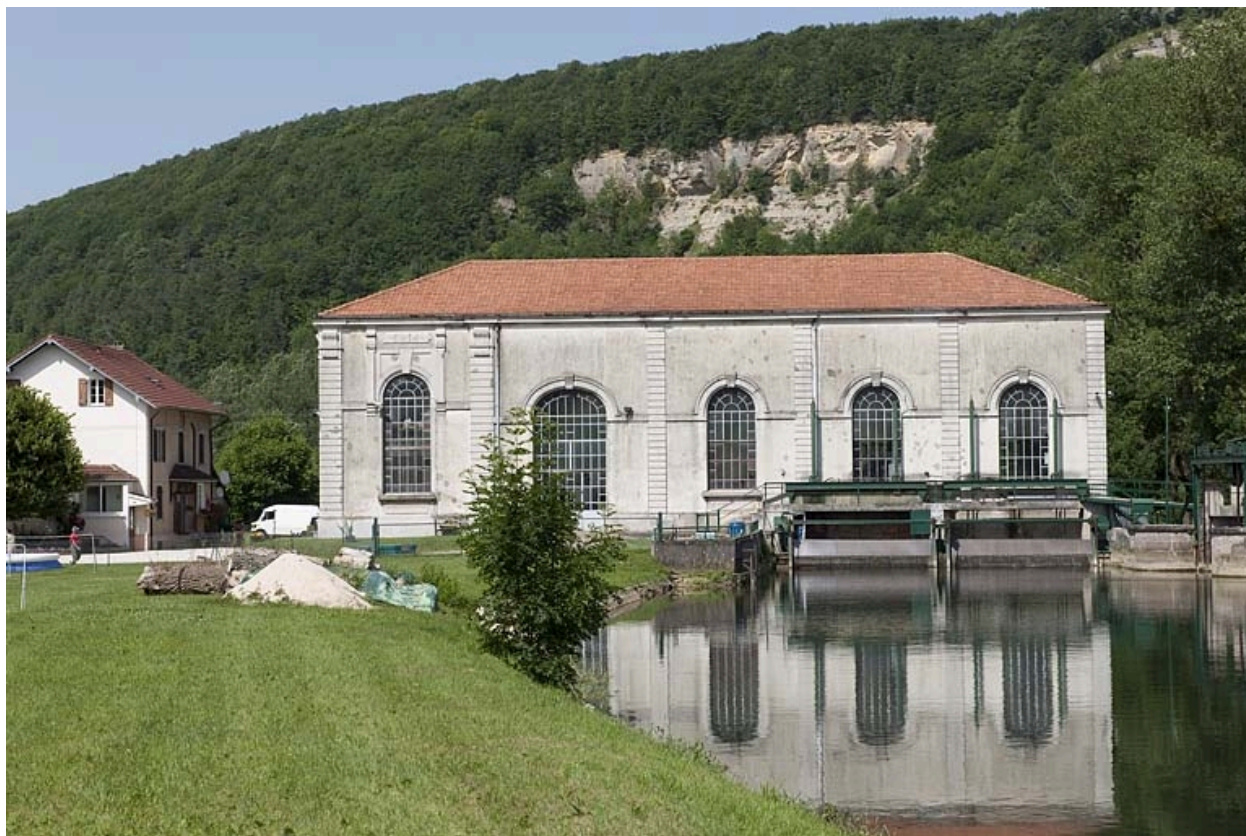
Façade sud de la centrale.
