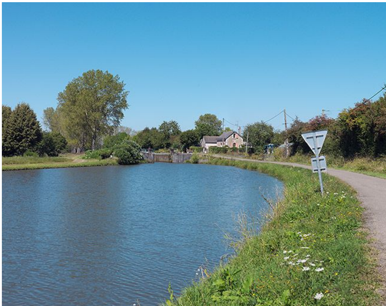
Vue d'ensemble du site prise d'aval.
