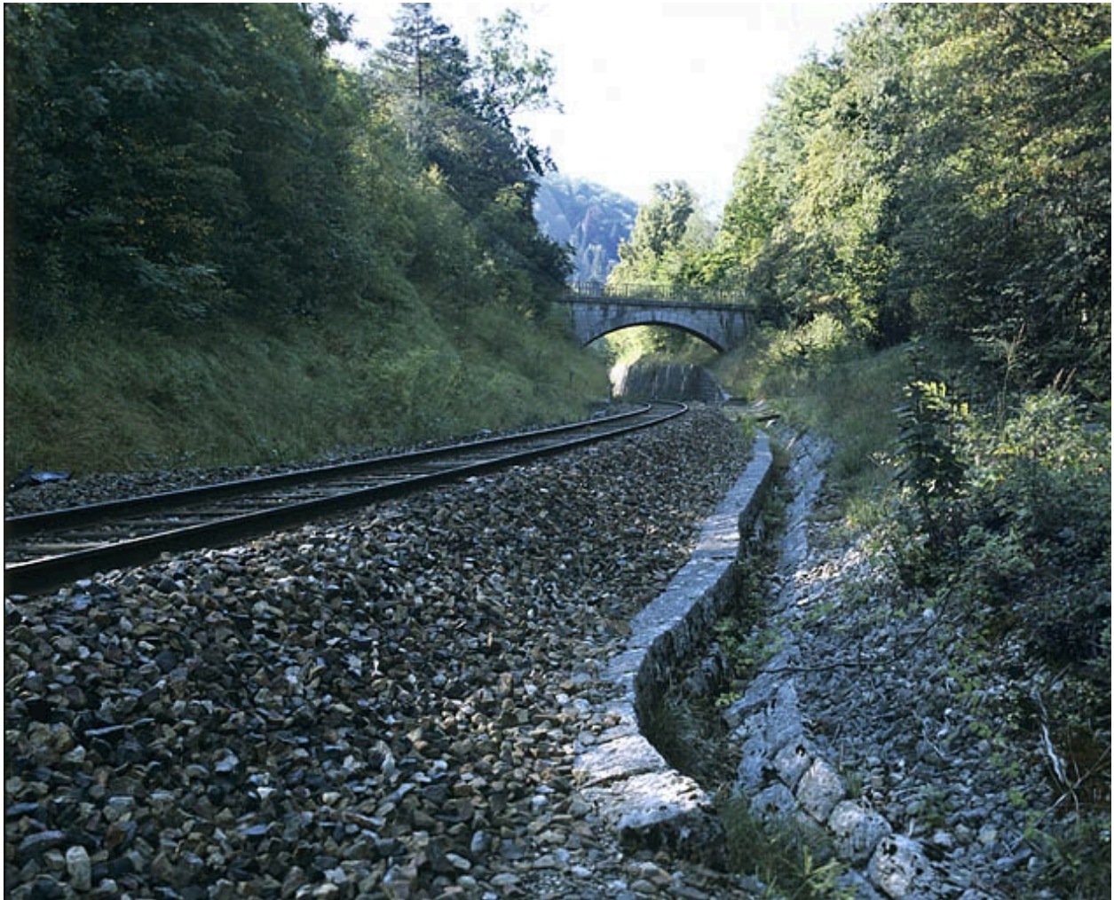
Vue d'ensemble, depuis le côté Andelot-en-Montagne (nord).
