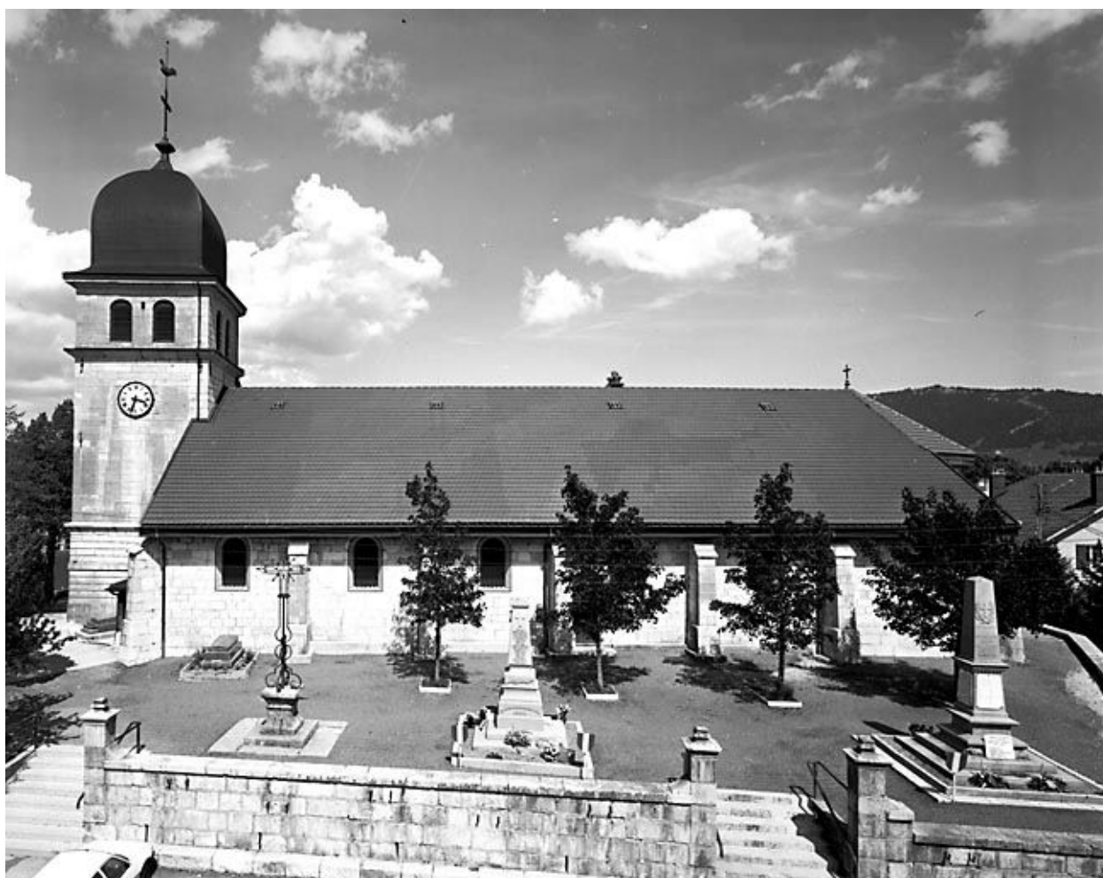
Façade latérale droite.
