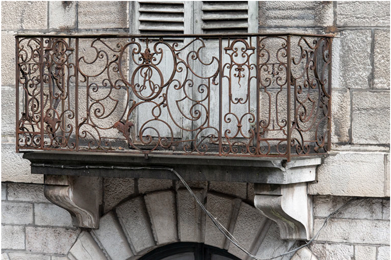
Ferronnerie du balcon (1er étage).
