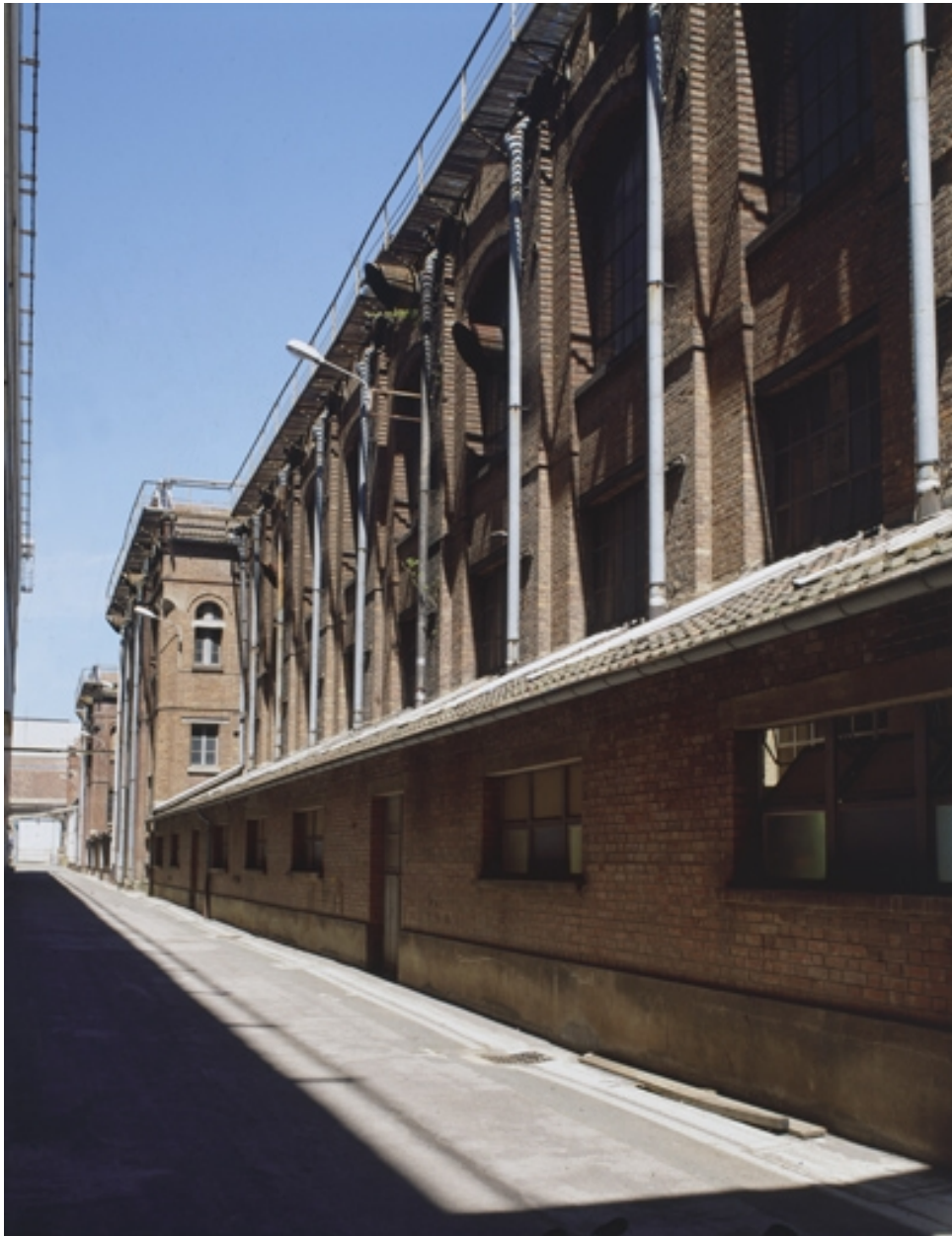
Façade ouest de l'ancien atelier des grandes dynamos.
