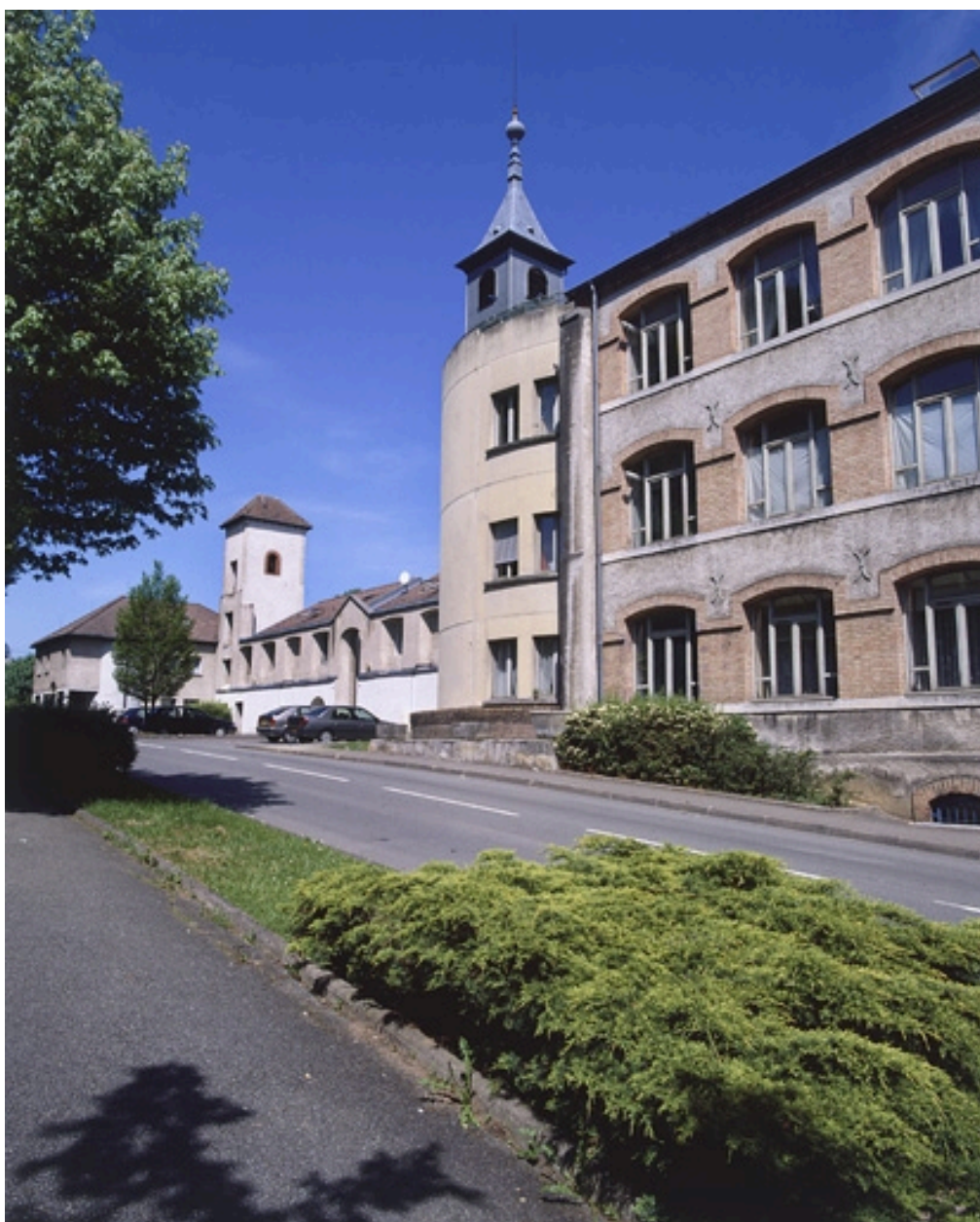
Façades sud depuis la rue Frédéric Japy.
