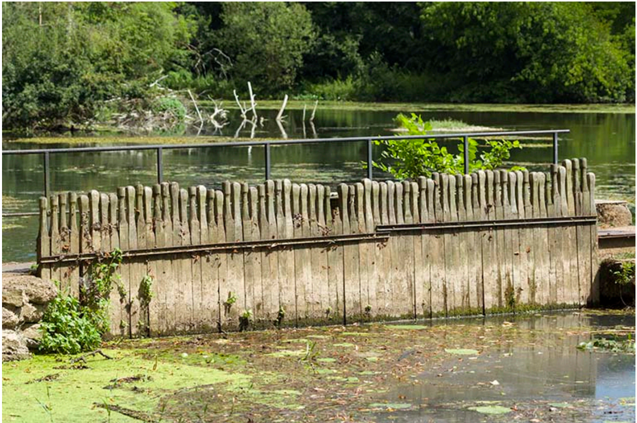
Aiguilles fermant l'ancien pertuis de navigation.
