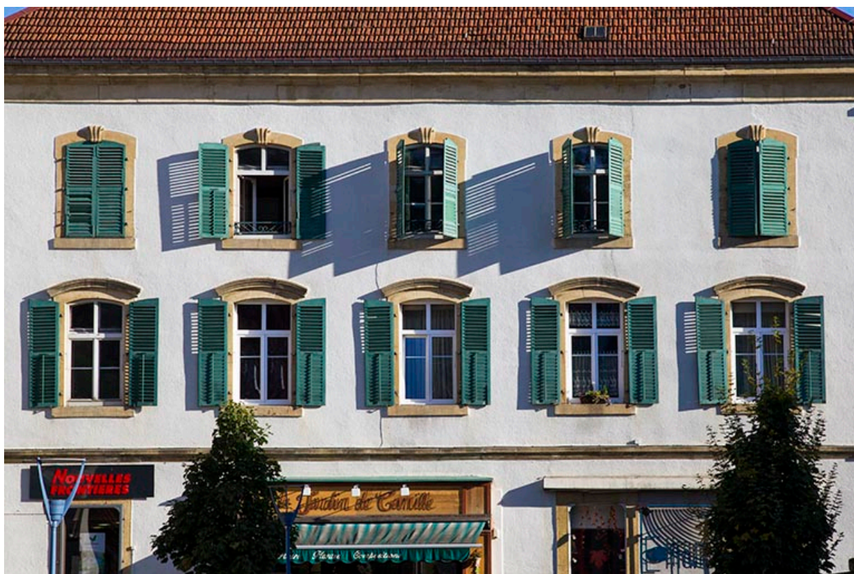
Façade antérieure : fenêtres des deux étages carrés.
