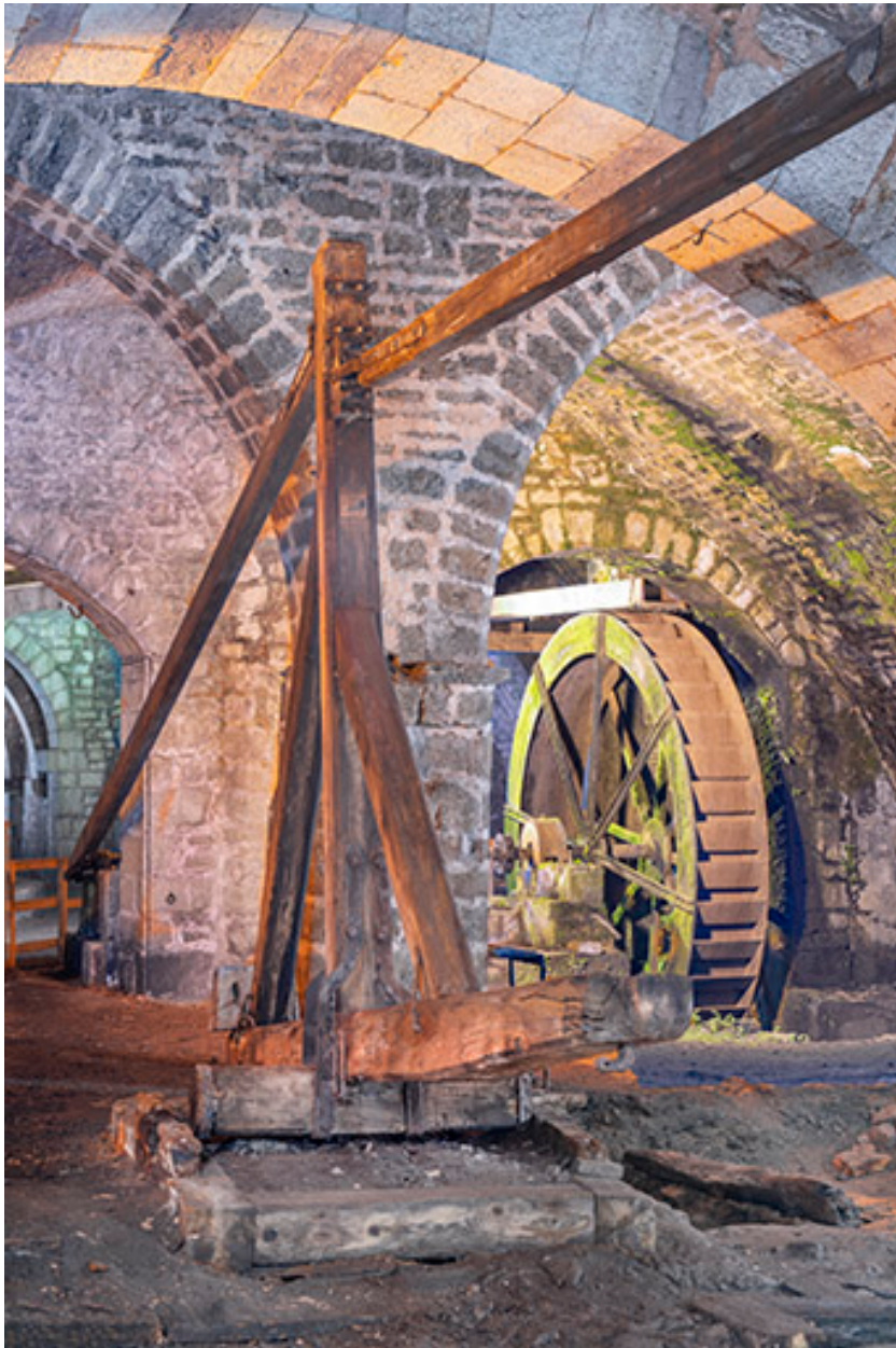
Puits d'Amont. Mécanisme hydraulique : roue à eau et balancier d'équilibre.
