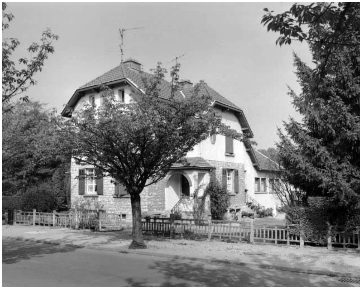
Façade antérieure et face droite.
