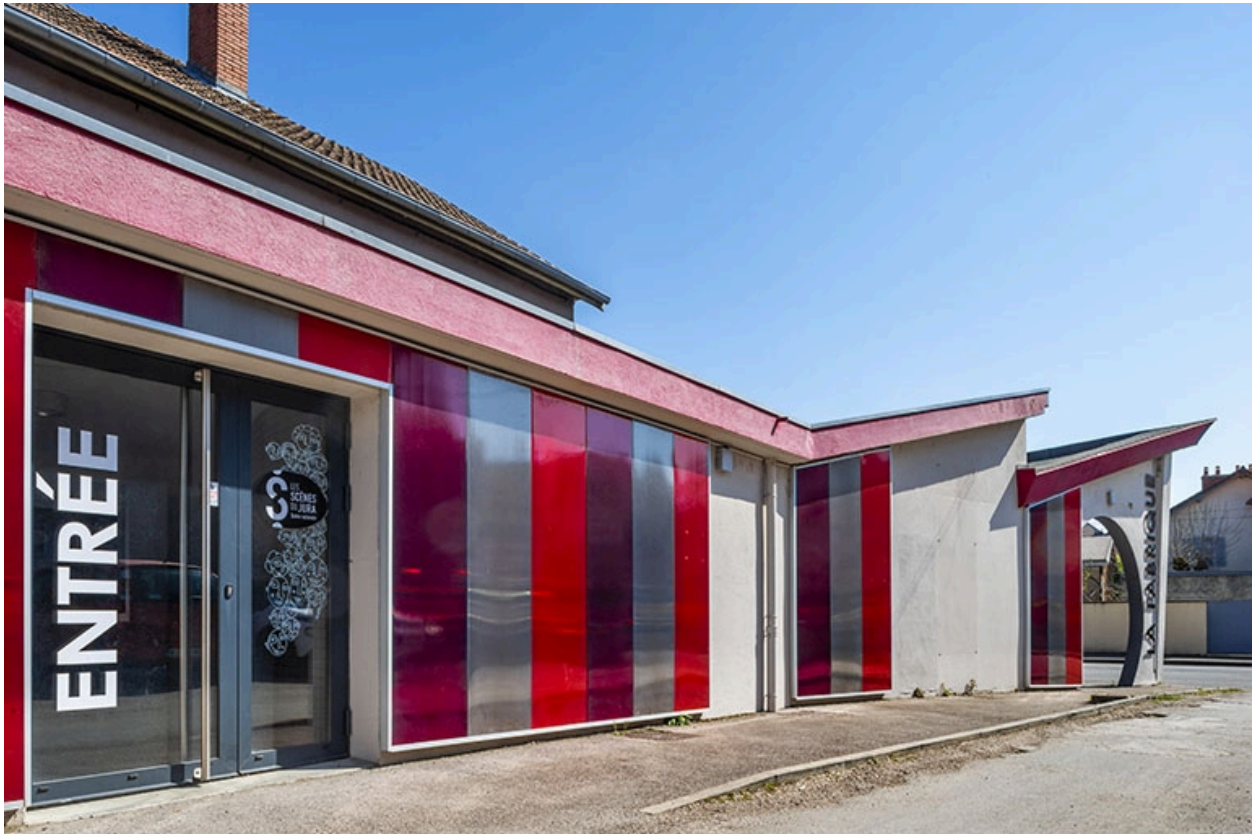
Façade latérale gauche : entrée et vestibule.
