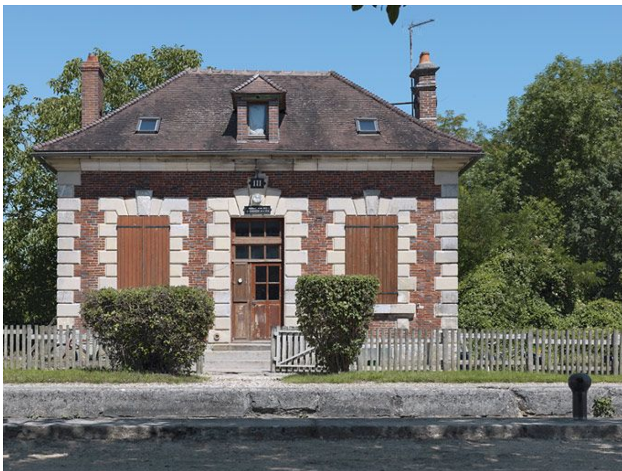
Maison éclésièr vue de face.
