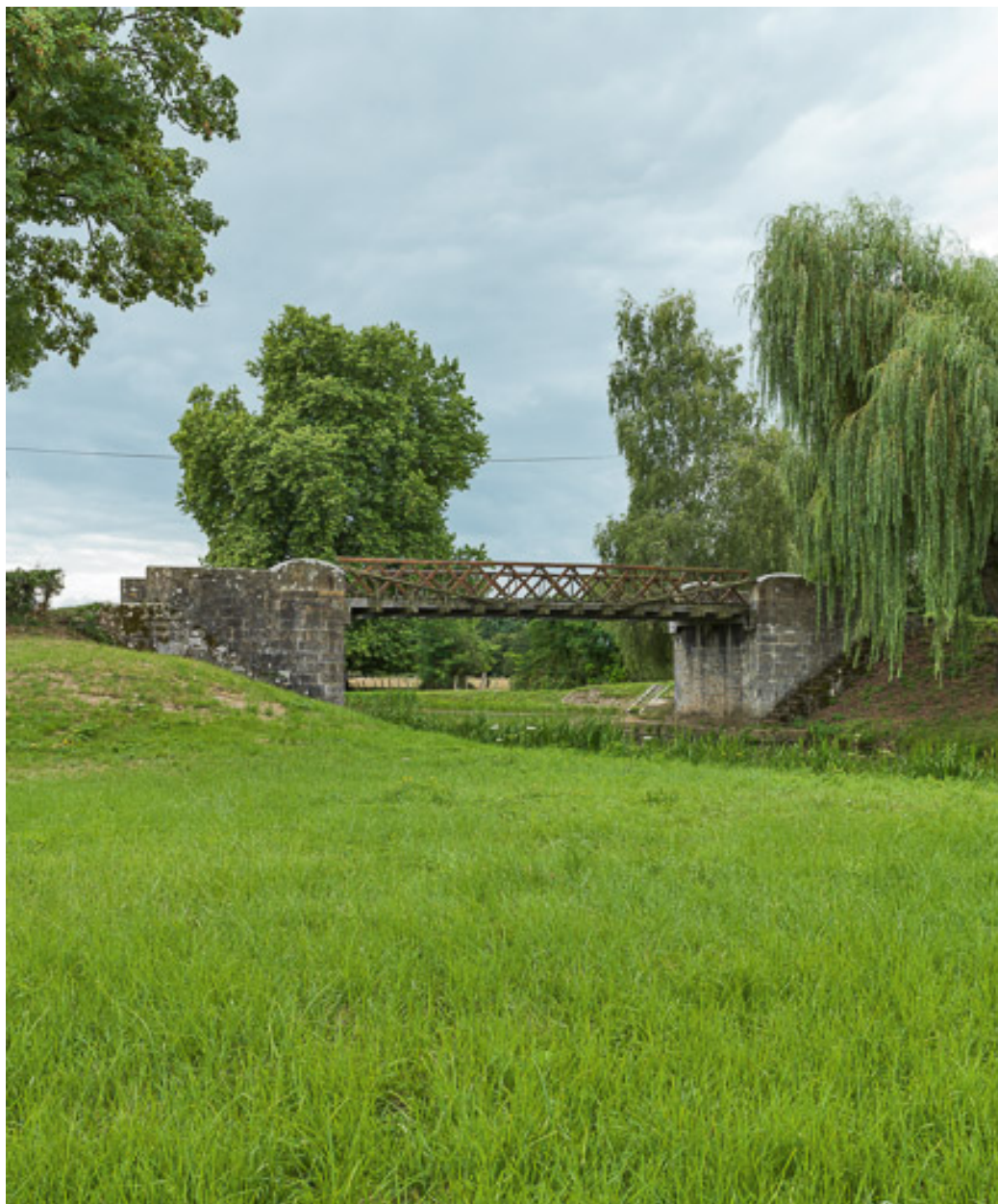
Vue de la passerelle.
