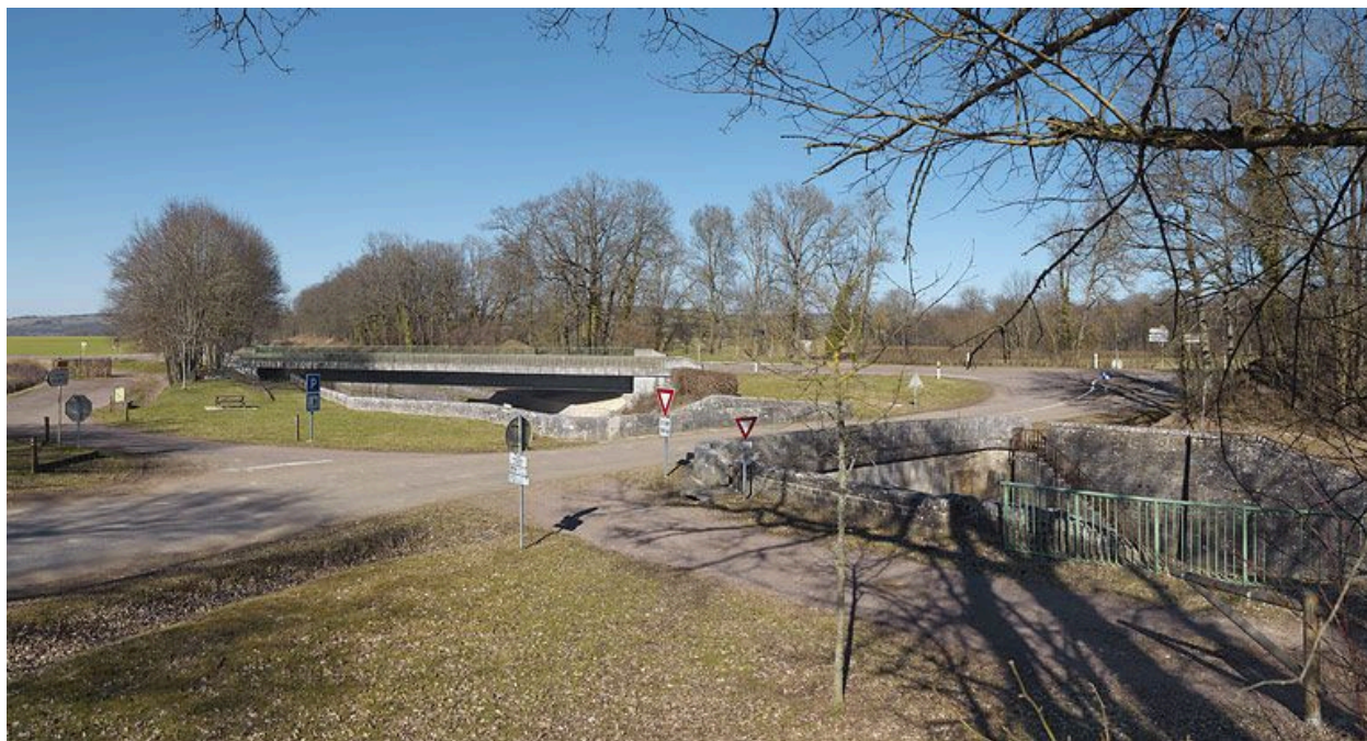
Vue d'ensemble des deux ponts.
