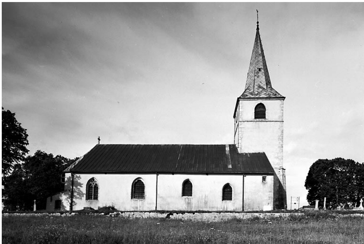
Façade latérale gauche.
