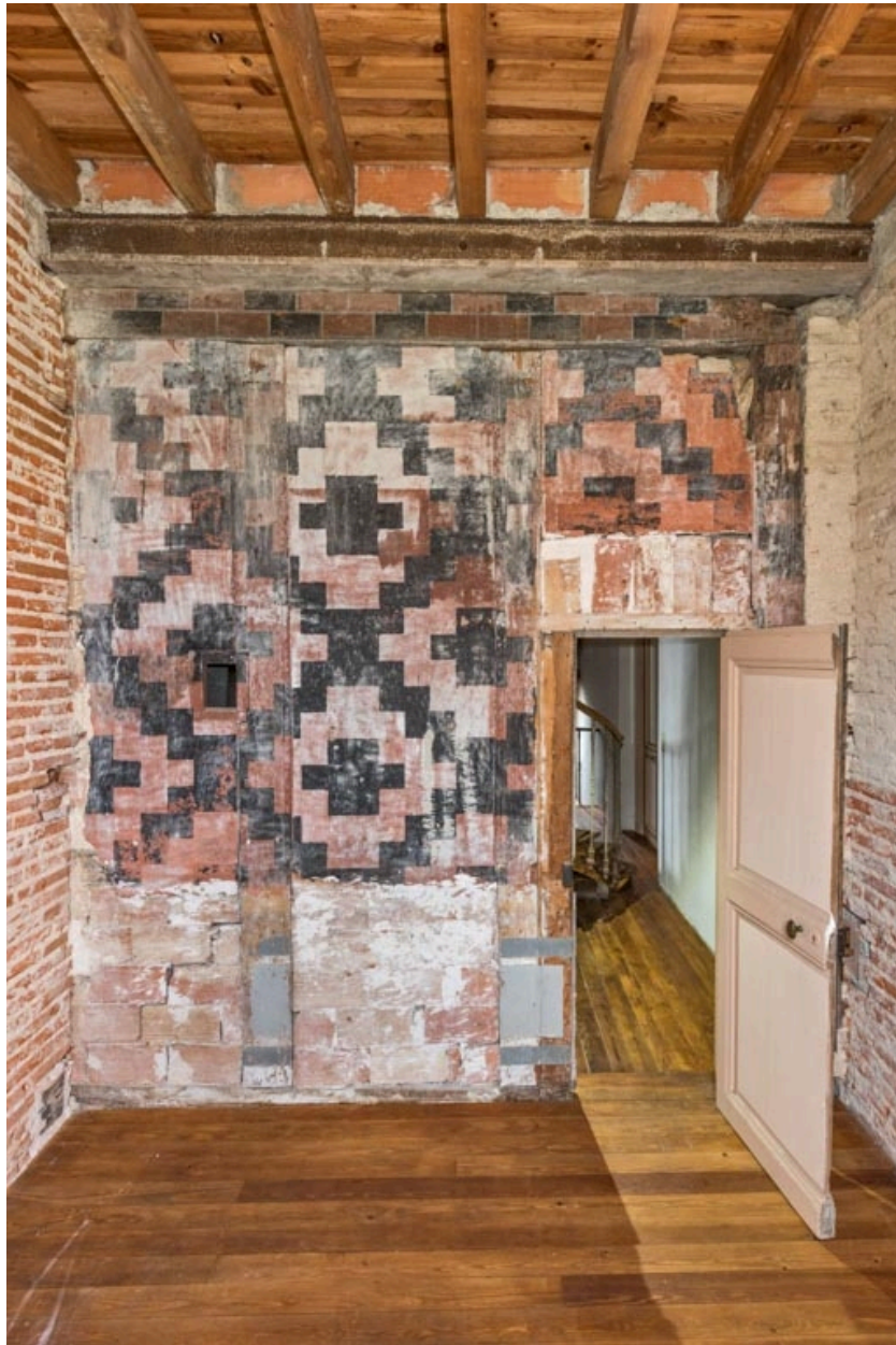
Corps sud, 1er étage : mur peint du fumoir.
