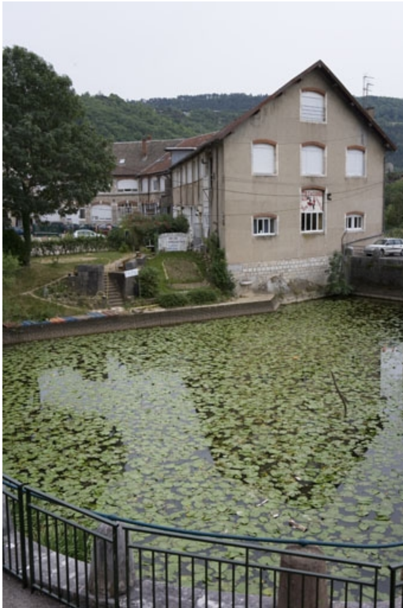
Façade latérale droite (amont) des ateliers de fabrication, de trois quarts gauche.
