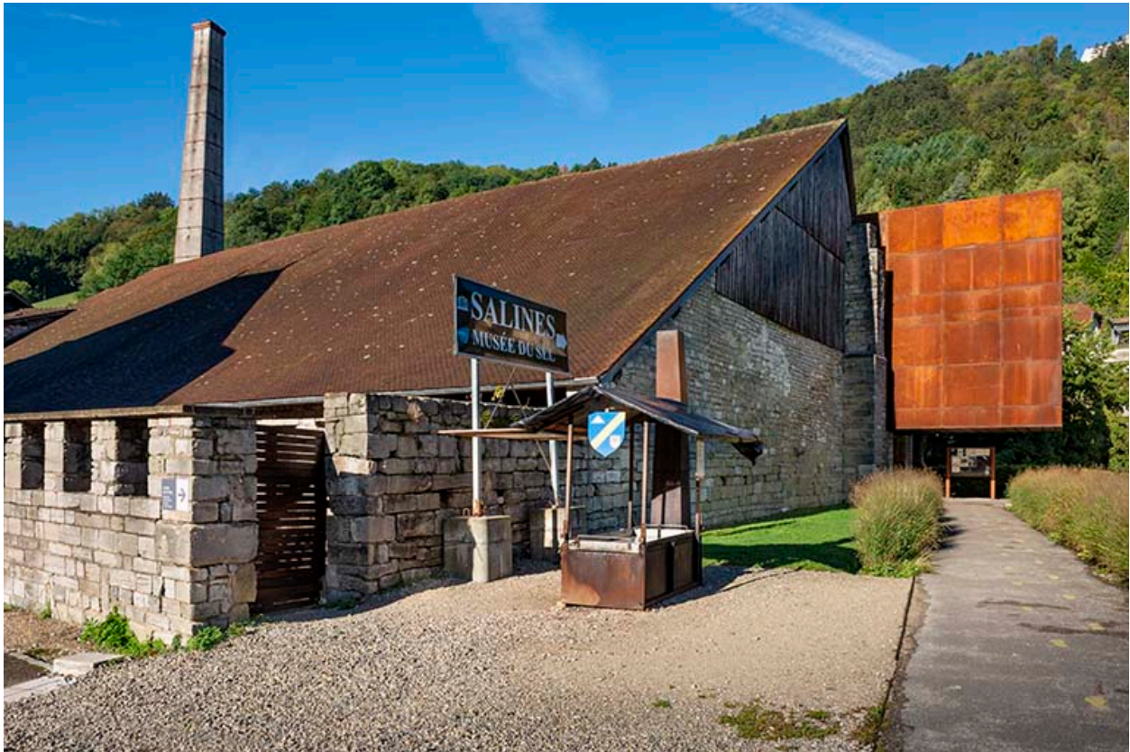
Vue de trois quarts du grenier à sel.
