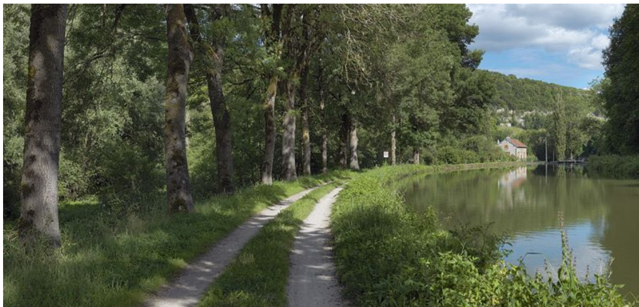
Vue large d'amont du site d'écluse 17.
