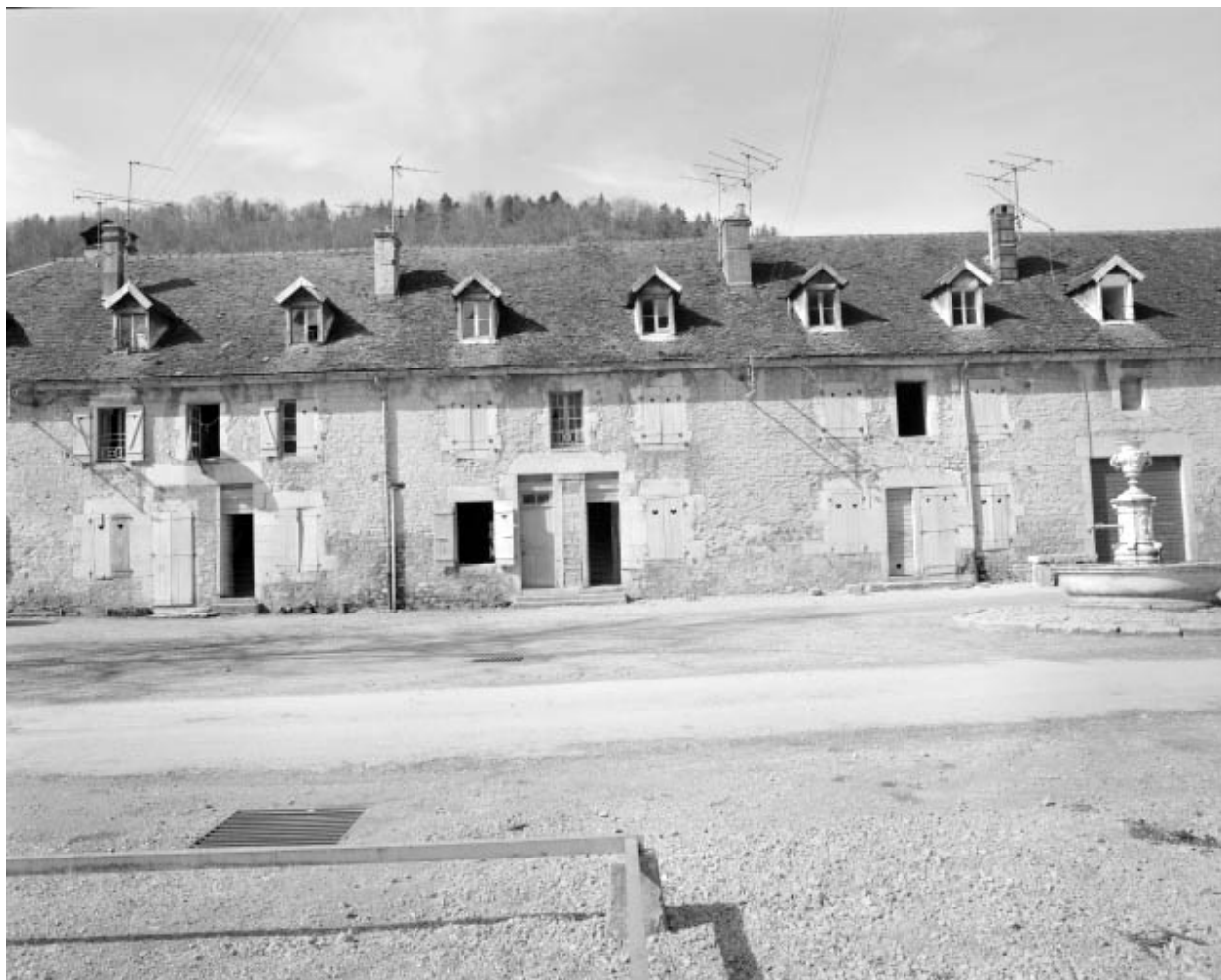
Façade du logement d'ouvriers.
