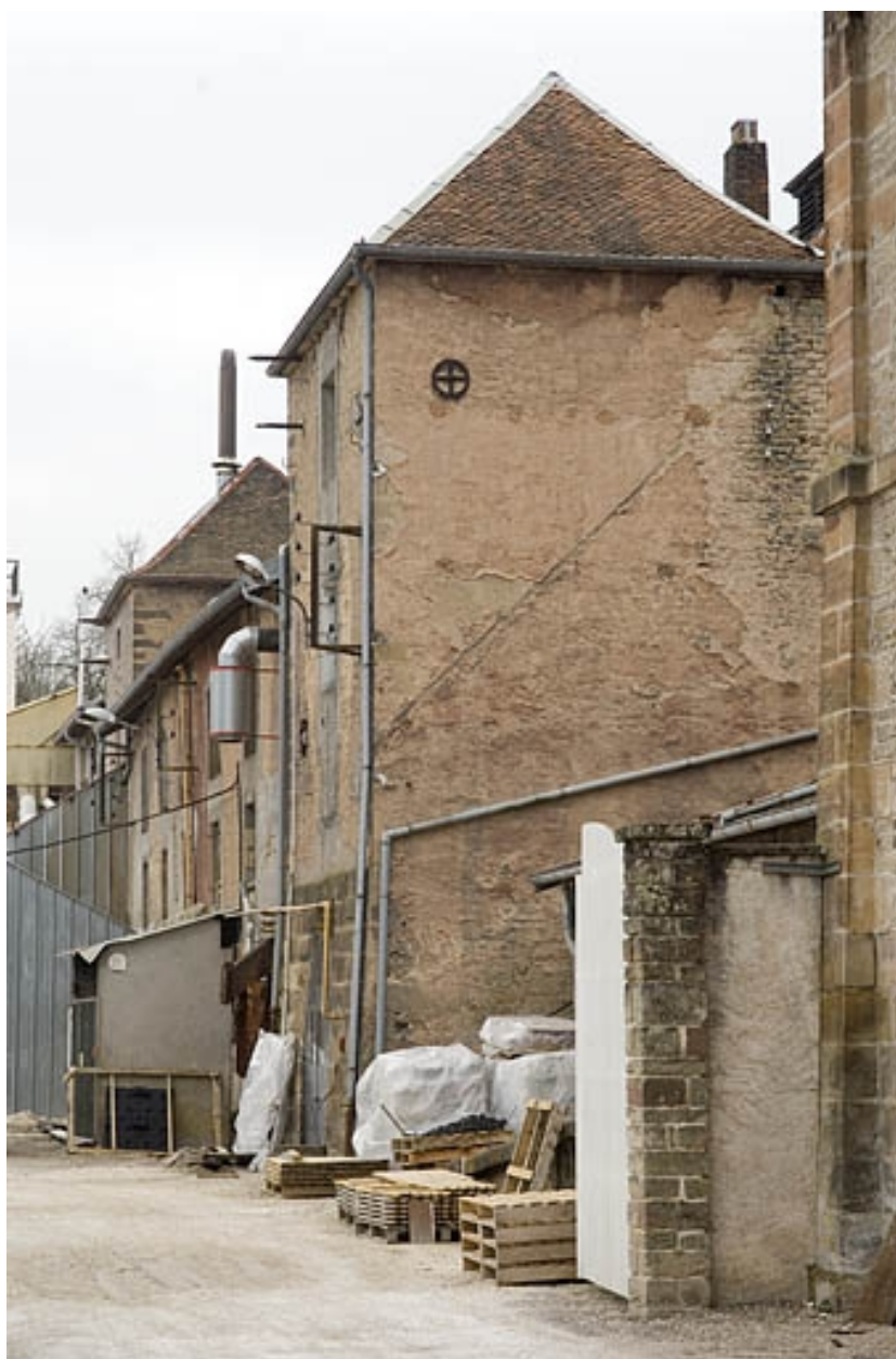
Façade postérieure de l'atelier des fours.
