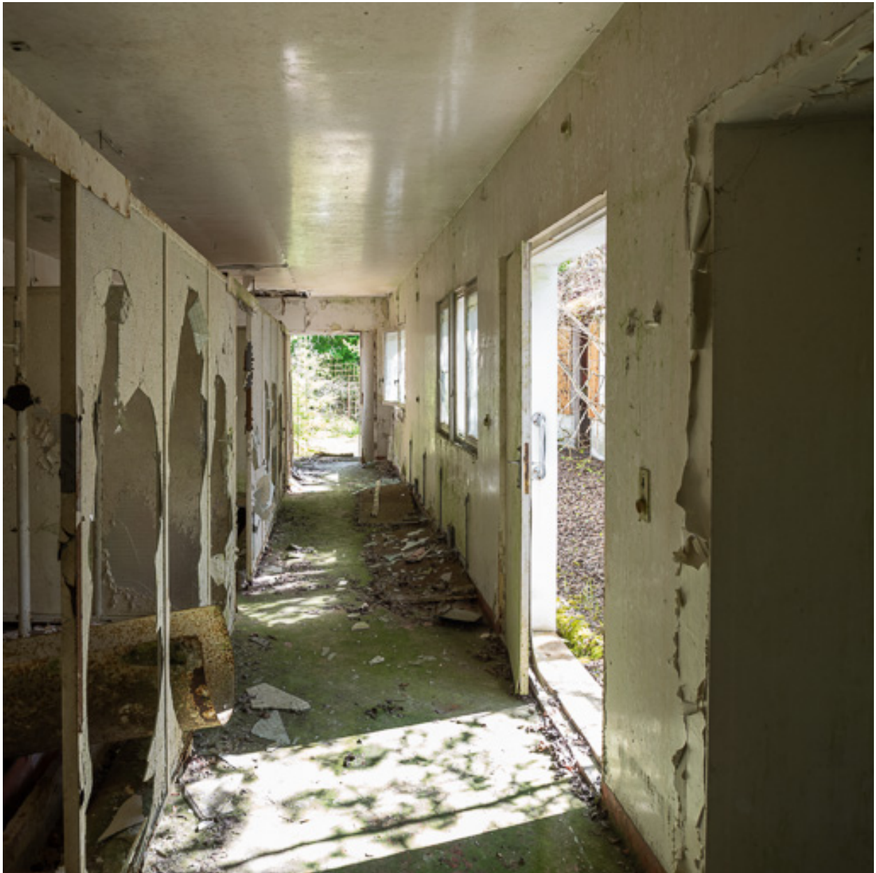
Bâtiment des bains, vue intérieure avec alignement des cabines.
