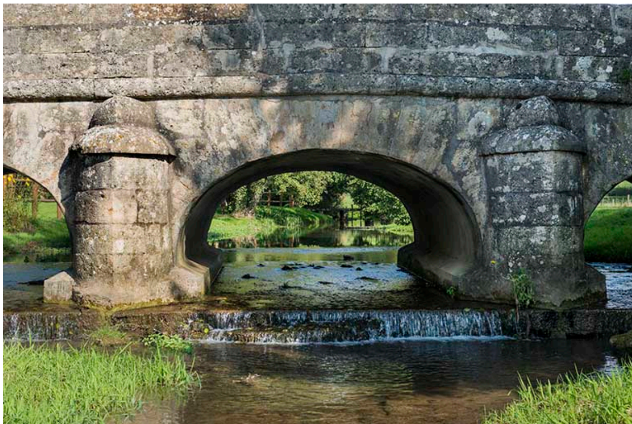
La voûte centrale.
