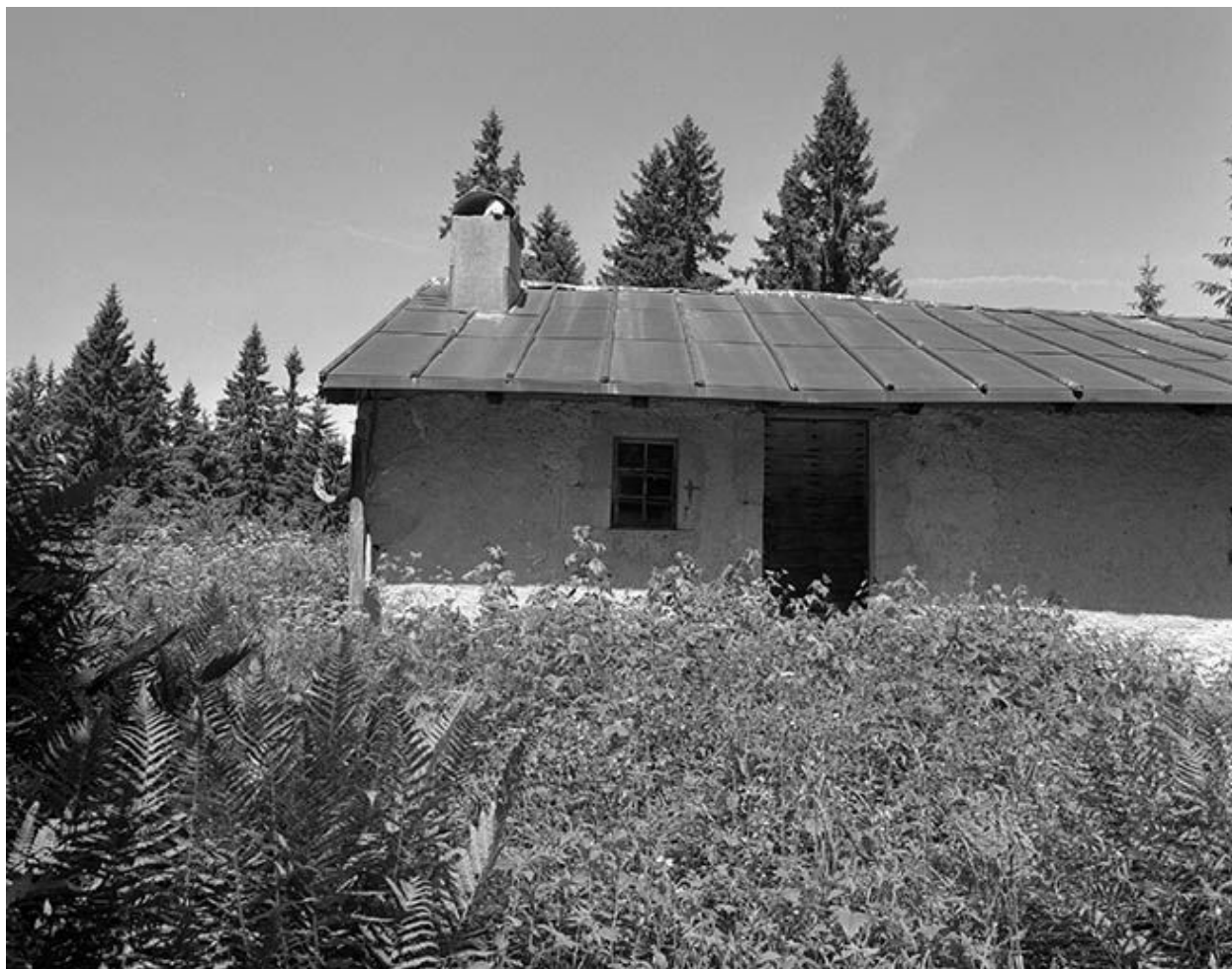
Porte d'accès de la façade antérieure.
