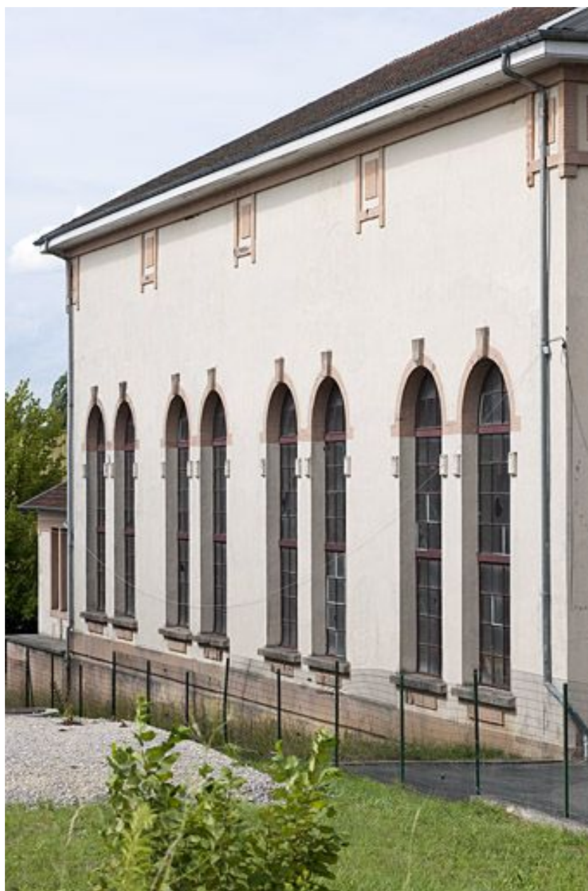
Façade ouest de la salle des machines.
