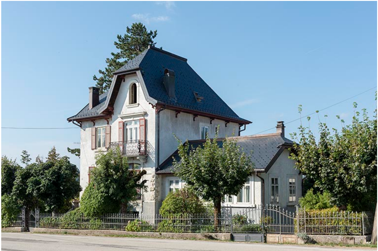
Façades antérieure et latérale droite.
