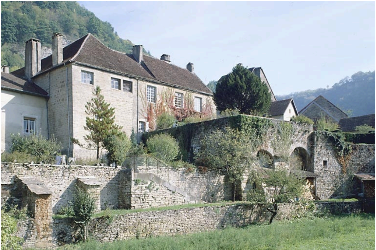
Face sud des maisons des chanoines.
