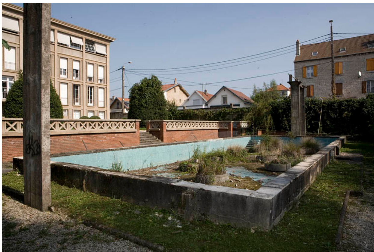
Piscine : vue de trois quarts.
