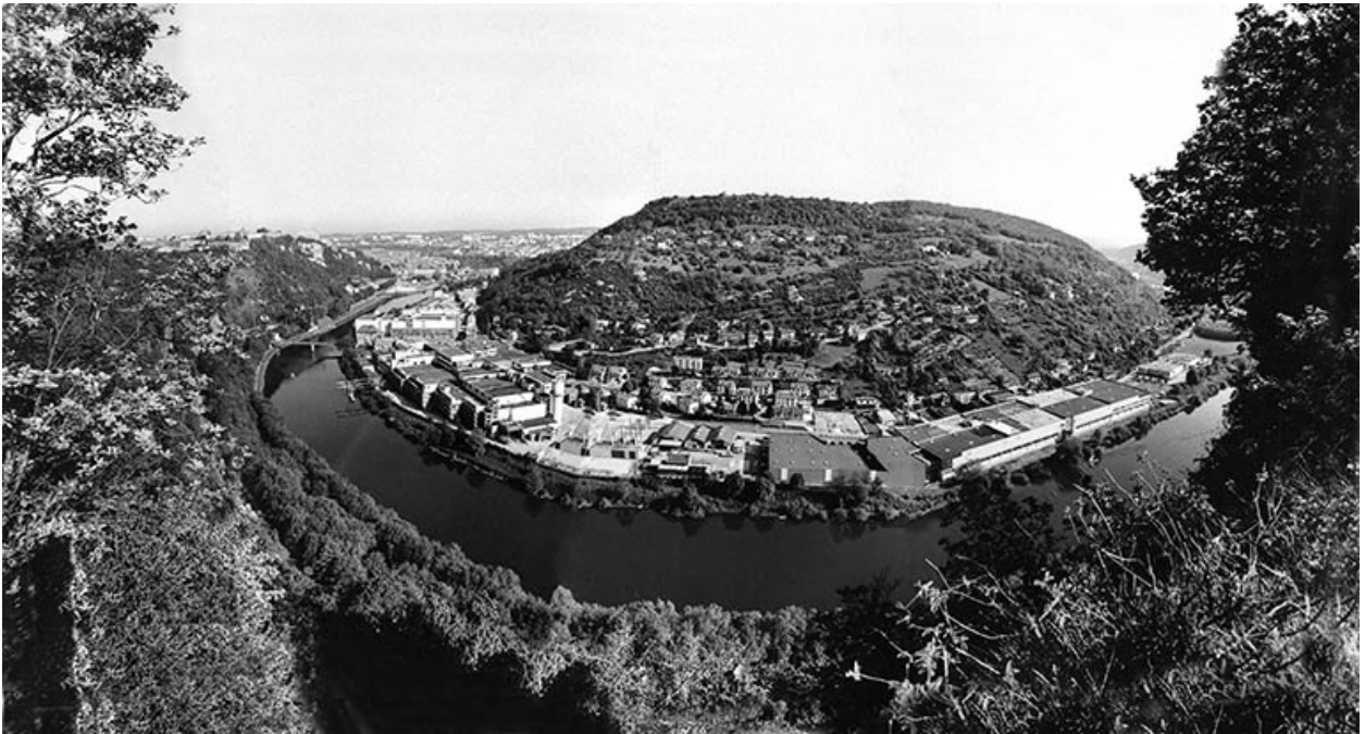
Vue panoramique depuis le sud. Montage de photographies.
