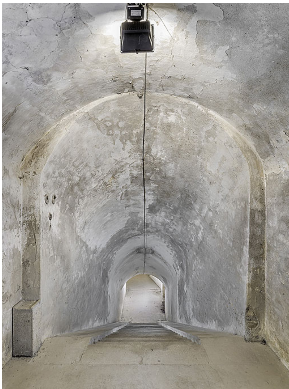
Escalier-rampe en direction de la double caponnière.
