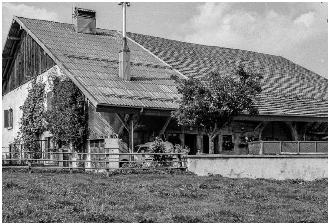
Ferme située rue du Bois-du-Désert : façades antérieure et latérale droite.
