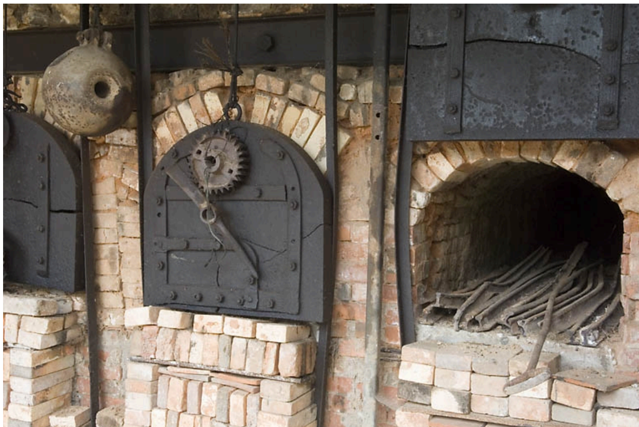
Tuilerie et briqueterie Janicot, Montureux-et-Prantigny. Gueules de charge du four, avec système d'ouverture à contrepoids.
