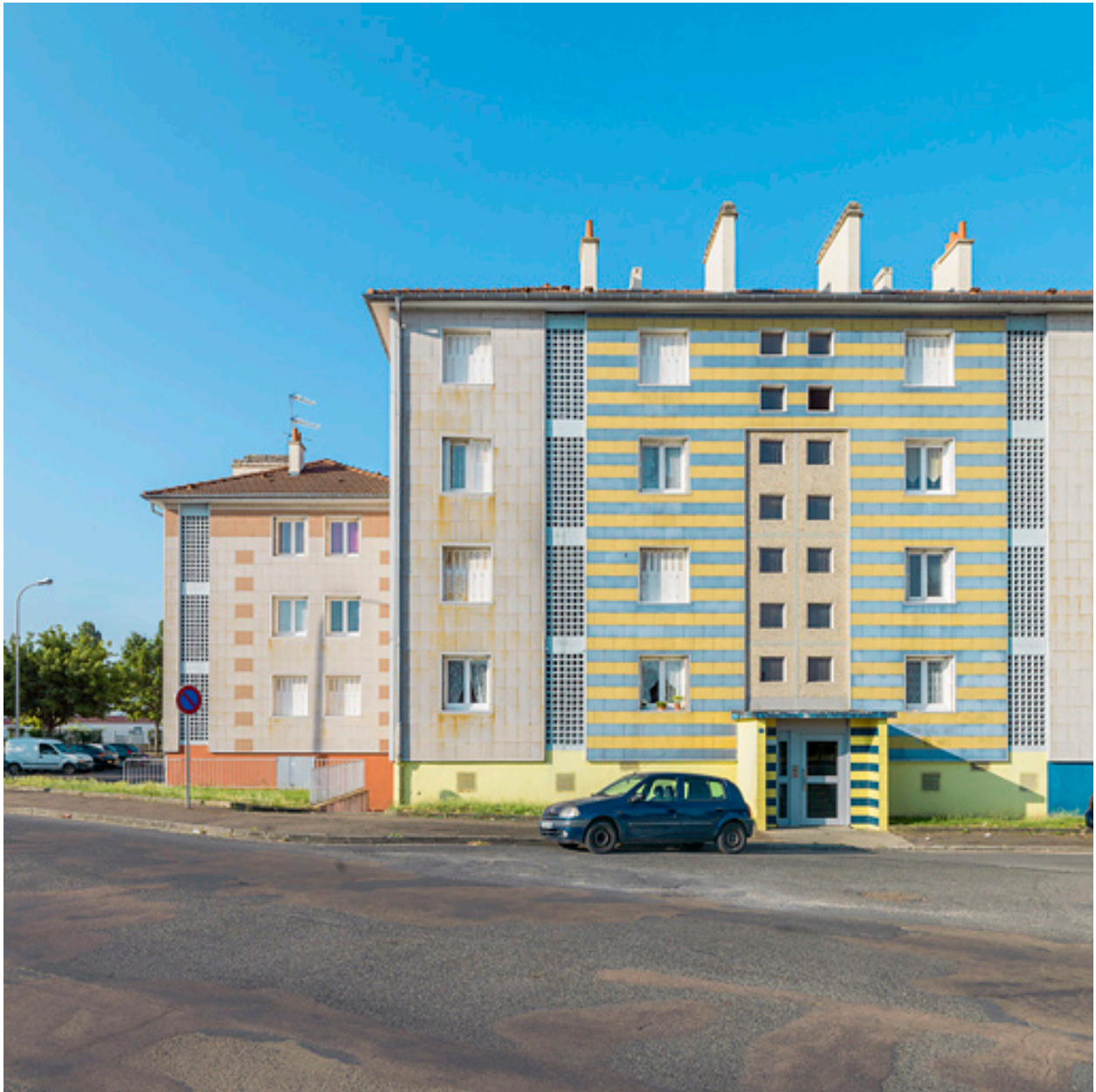
Bâtiment A, façade antérieure.
